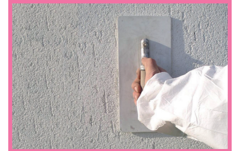
Malzeme çelik mala ile yüzeye eşit kalınlıkta yayılmalı, uygulama kalınlığı en iri desen taşına göre ayarlanmalıdır
