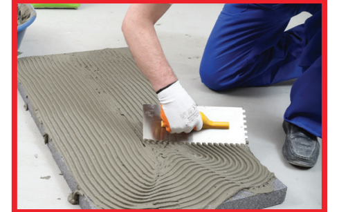
Hazırlanan karışım mala yardımı ile ısı yalıtım levhasının tamamına uygulanır. (Taraklı)
