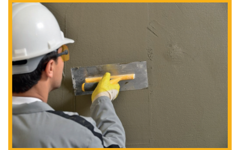
Hazırlanan karışım mala yardımı ile ısı yalıtım levhasının tamamına uygulanır.
